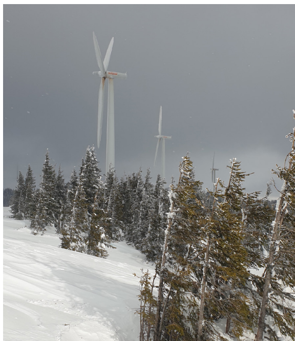
Turbinele eoliene furnizează, de asemenea, multă energie electrică și pe timp de iarnă
